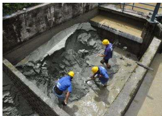
Figuras 2 y 3. Arrastre de material con altos niveles de turbiedad del río Combeima en época de lluvia. Limpieza manual de desarenadores por presencia de sedimentos.
